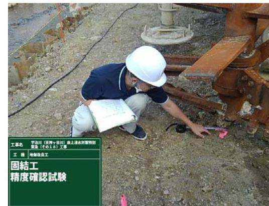
精度確認試験を行いました。通常のキャリブレーションに杭芯位置精度確認試験が増えます。
