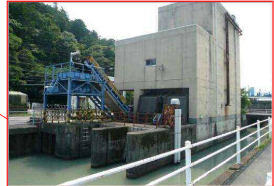
鹿見川排水機場
