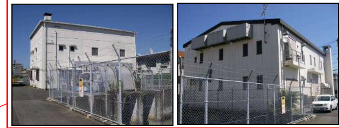
鹿見第2排水機場
