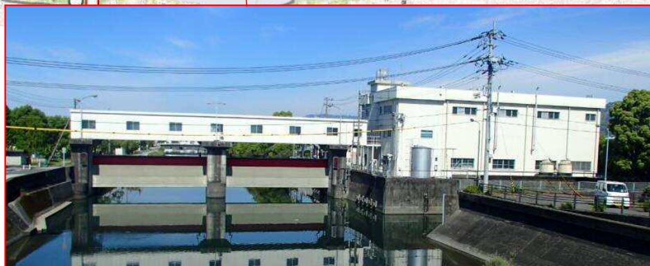
江ノ口川排水機場
