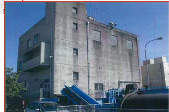
本江田排水機場
