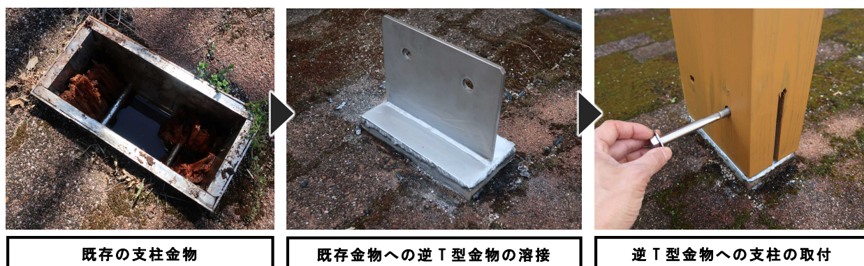
図4 木製看板の修繕状況
