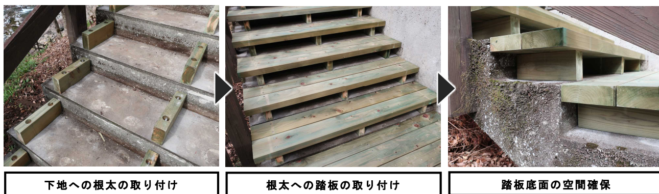
図3 木製階段の修繕状況
