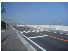
海岸堤防の耐震補強状況
