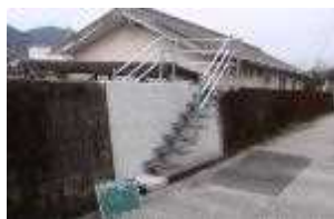
コンクリートによる陸ごうの閉鎖
