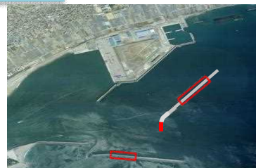
高知港防波堤の整備
