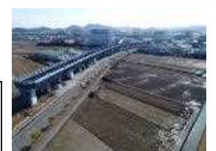
高知東部自動車道 高知南国道路 (高知市)
