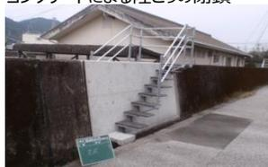
海岸堤防の耐震補強状況      コンクリートによる陸こうの閉鎖
