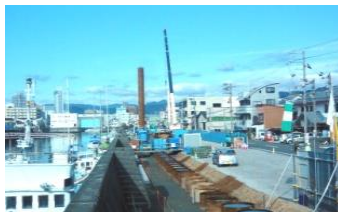
海岸堤防の耐震補強状況
