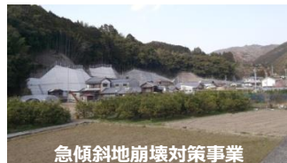
急傾斜地崩壊対策事業
