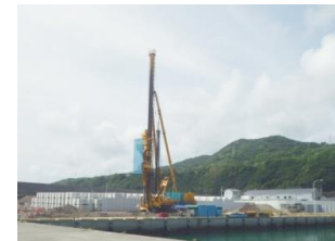
防災拠点漁港の岸壁耐震化
