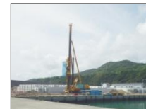
防災拠点漁港 の岸壁耐震化
