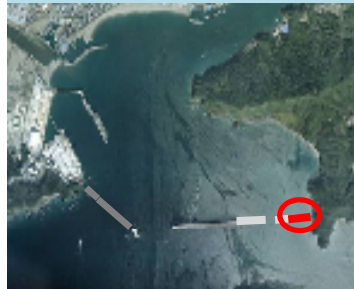
須崎港防波堤の整備
