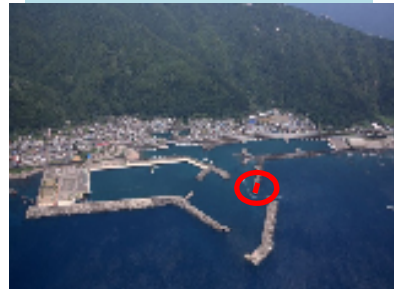
室戸岬漁港防波堤の整備
