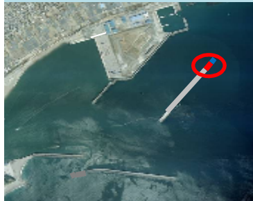
高知港防波堤の整備
