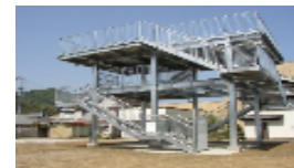
(東洋町白浜第1津波避難タワー)
