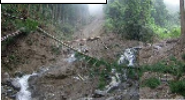
治山対策例(施工前)
