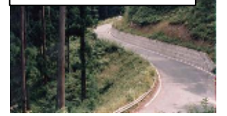
林道開設施工後
