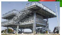
(四万十市下田津波避難タワー)
