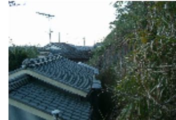
(家屋裏の急峻な崖地)
