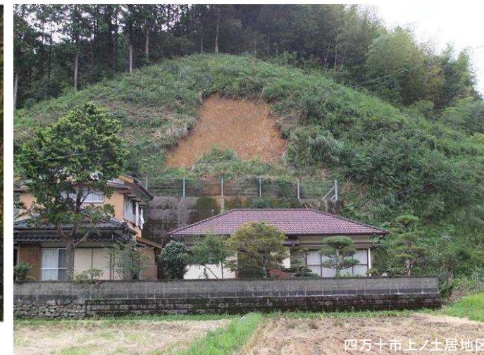
四万十市上ノ土居地区のがけ崩れ
