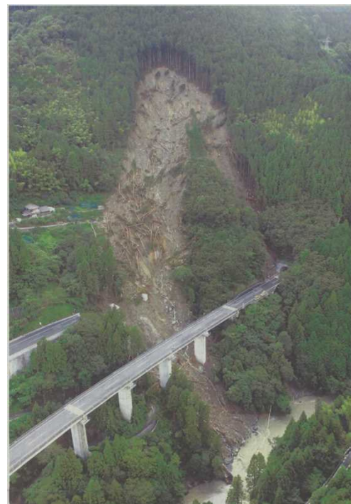
大豊町立川上名地区の斜面崩壊 (高知自動車道の橋梁の流出)
