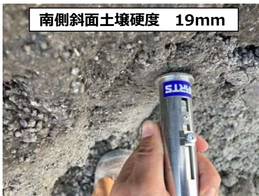
山中式土壌硬度計による測定 (R5. 6月測定)
