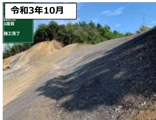
1:2.0勾配斜面 施工直後の状況
