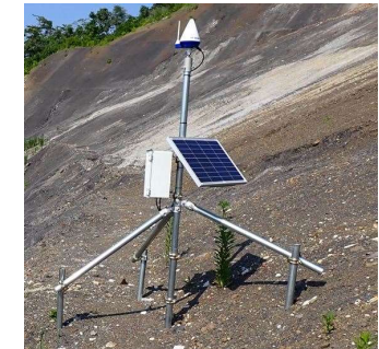
GNSSによる観測状況
