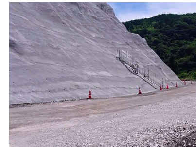
工事用道路の整備状況
