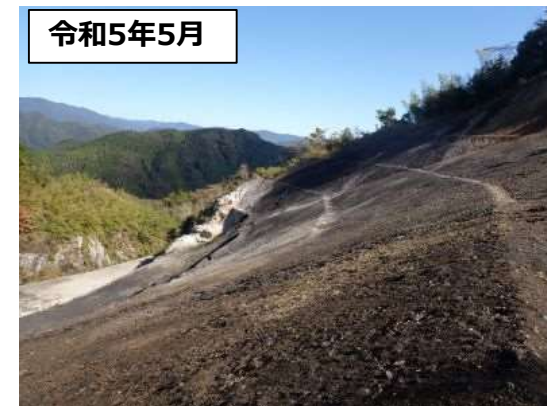
1:2.0勾配斜面 施工後1年7カ月以上
