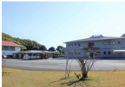
○障害者スポーツセンター
