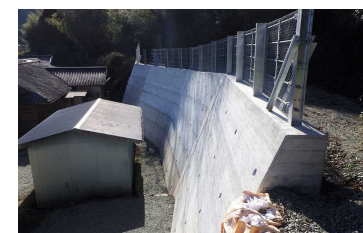
<土砂災害対策(急傾斜地崩壊対策事業)>
