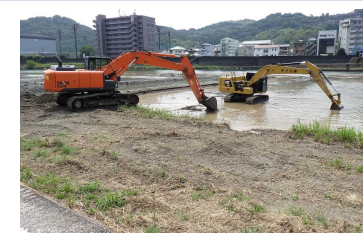
<河川に堆積した土砂の浚渫>
