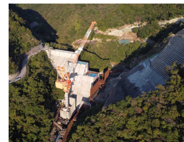
<建設中の和食ダム>
