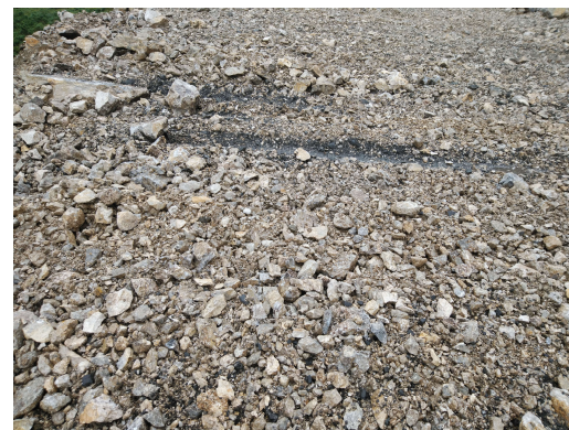
現在、施工中の工事用道路の工事で掘削された石灰岩
