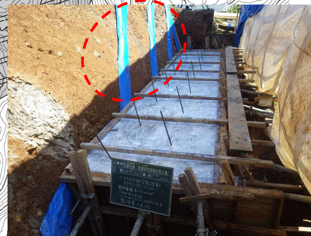
斜面に設置する面状排水材（例）
