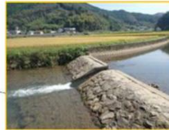
固定堰により、洪水が流れる断面が縮小
