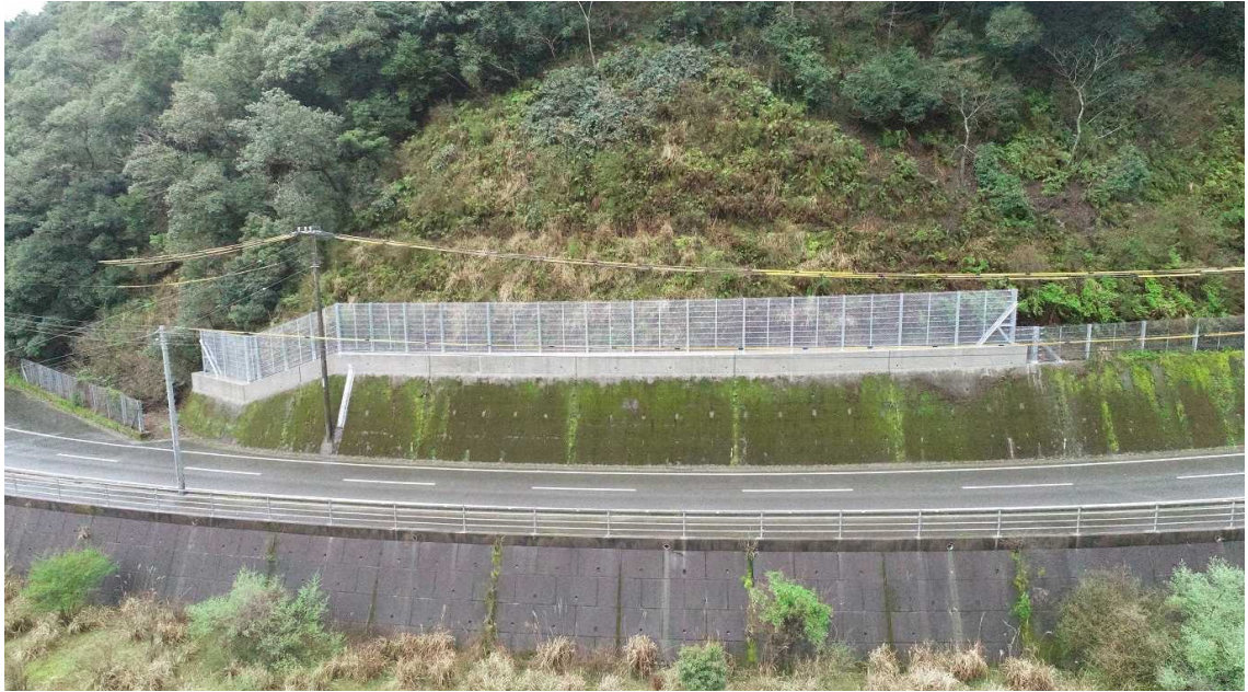
落石防護柵工 L=52.0m 排水工 L=38.0m
