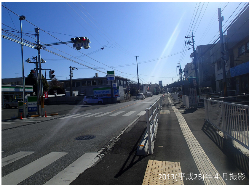
県道南国インター線（ファミリーマート大桶店前） 【整備前】
