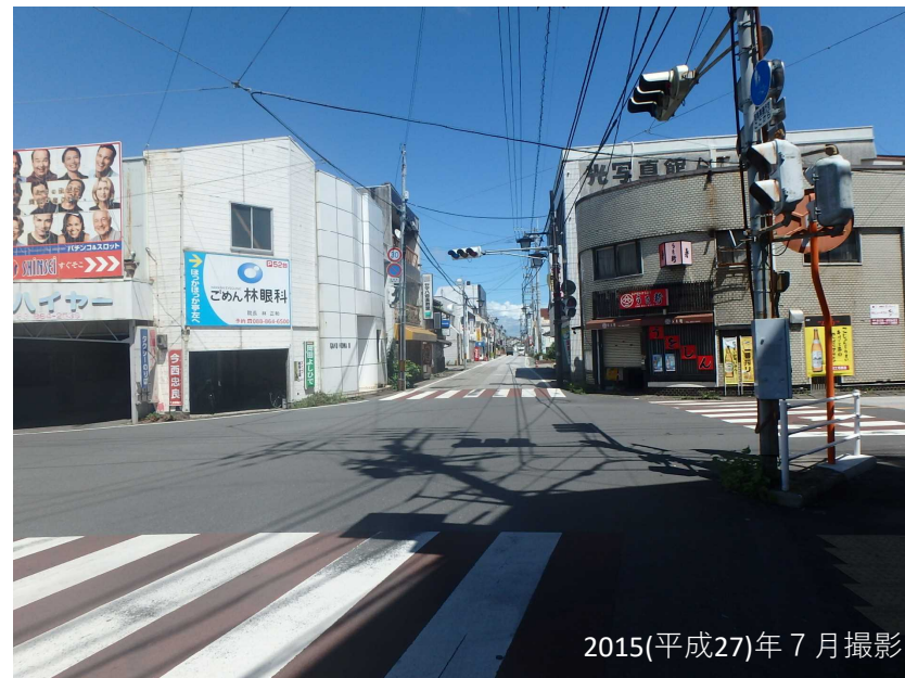
県道南国野市線（後免東町交差点東側） 【整備前】
