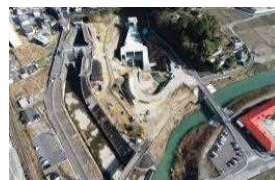
日下川 (放水路整備)
