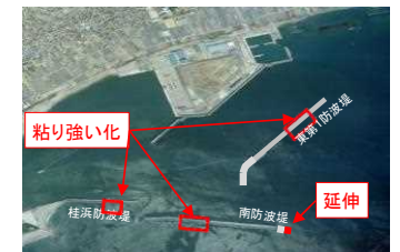
高知港防波堤の整備
