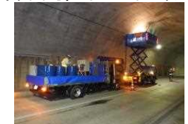
歯朶ノ浦トンネルの補修状況
