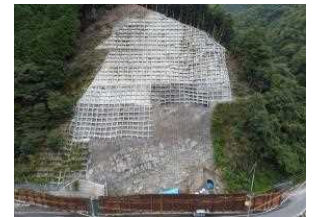
安田東洋線 (安田町正弘～北川村二又地区)
