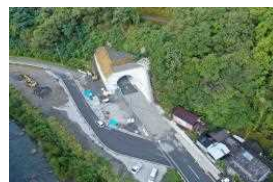
安田東洋線におけるトンネル整備
