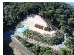
安満地福良線における線形改良
