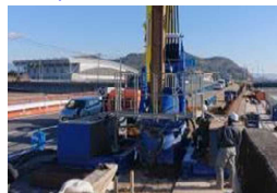
河川堤防の耐震対策
