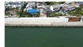
海岸堤防の耐震補強状況
