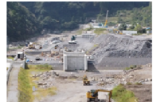
国道493号 (北川道路2-2工区)
