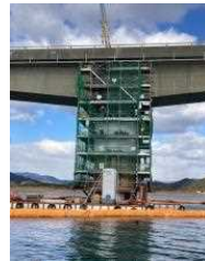
須崎仁ノ線 仁淀川河口大橋
