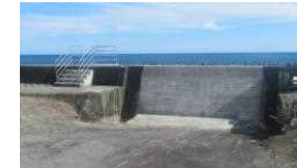
コンクリートによる陸こうの閉鎖
