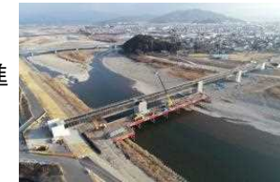
高知東部自動車道 南国安芸道路 (香南市)
