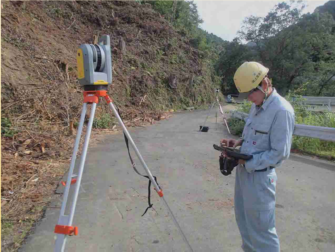
ワンマンにて3次元測量
