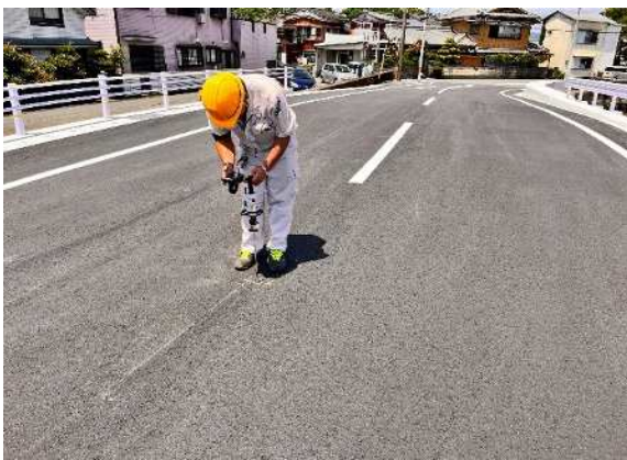
出来形測定状況(No.2)
