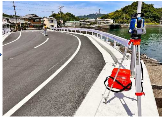
出来形測定状況(No.2)
