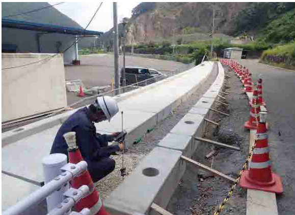
出来形測定作業 (No41 W=3. 10: GP基礎)
