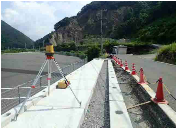
既知点測定状況 (K-19測定)
