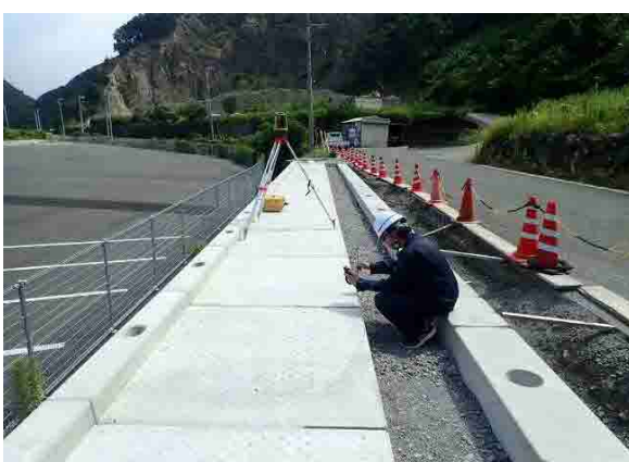
出来形測定作業 (No42 W=3. 70: 張出歩道)
