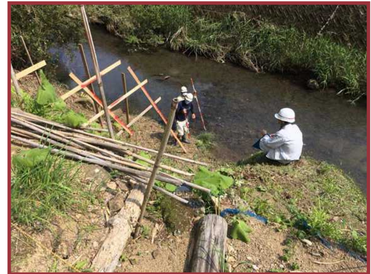
発注者との現地協議 (構造物位置)
