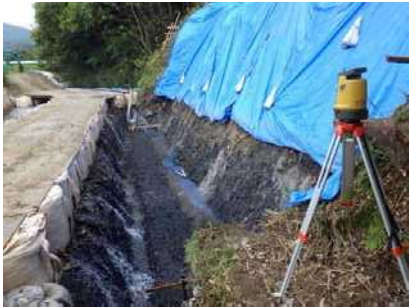
床掘開始前 杭ナビ設置
