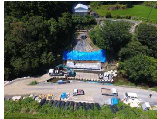
ブロック積施工状況
