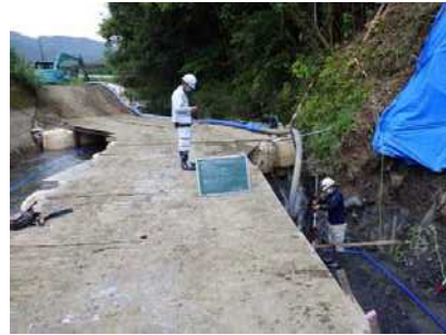
床掘終了後 立会
