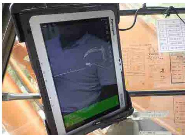
マシンガイダンスによる法面整形
