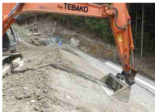
マシンガイダンスによる法面整形
