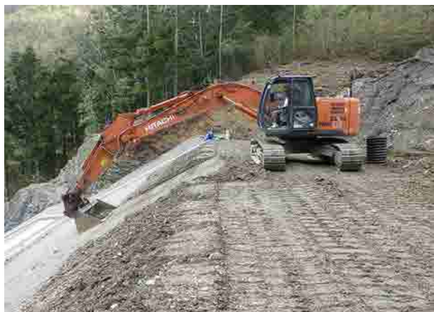
マシンガイダンスによる法面整形
