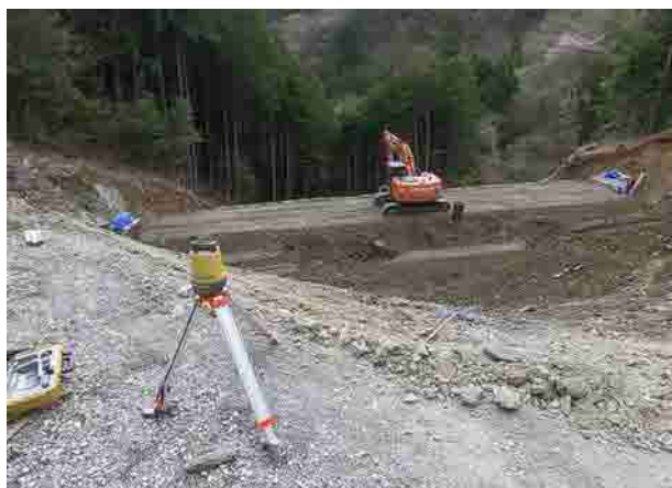
マシンガイダンスによる法面整形
