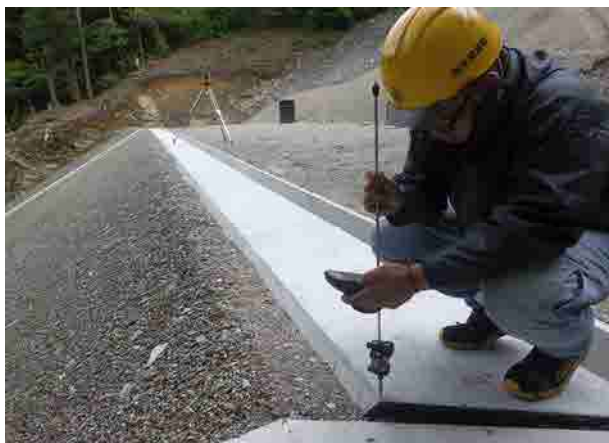
杭ナビによる出来形検測
