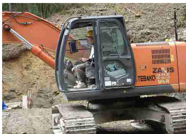
マシンガイダンスによる法面整形
