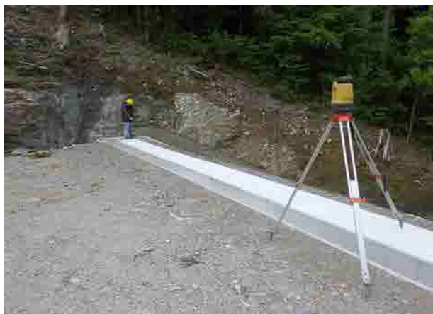
杭ナビによる出来形検測
