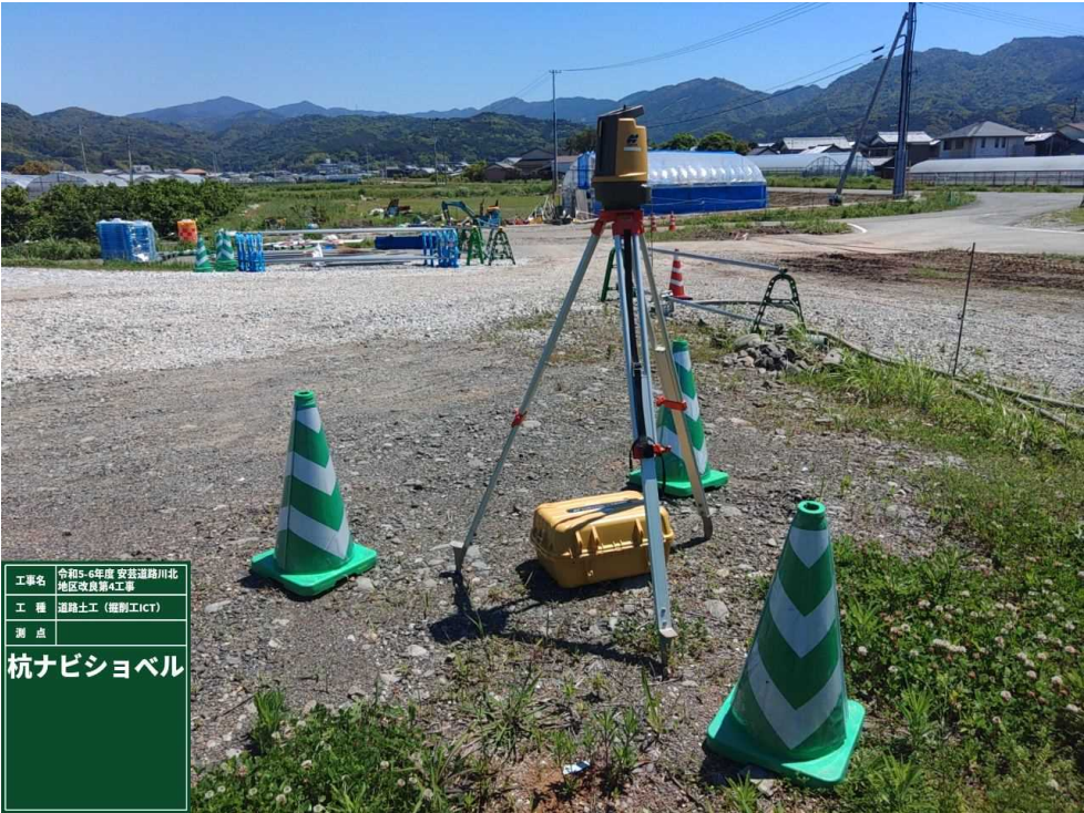
マシンガイダンスによるICT道路土工
