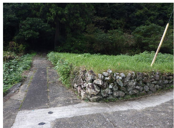
3号擁壁施工前
