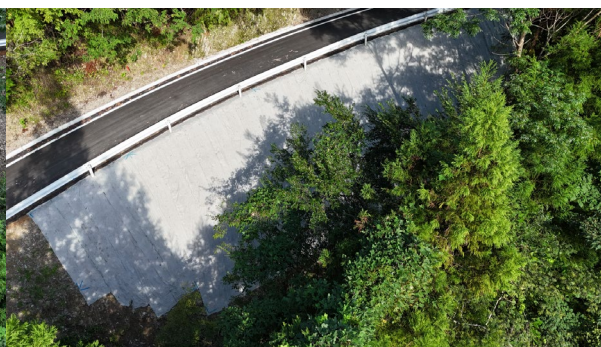
植生シート張り完了
