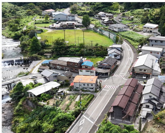
施工前の空撮
