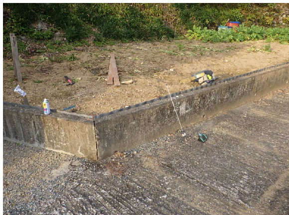
2号擁壁施工前
