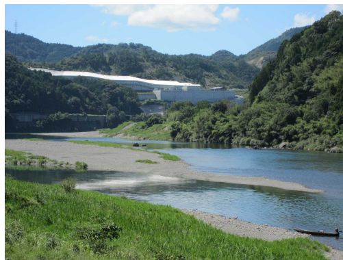
エコサイクルセンター（管理型最終処分場）
