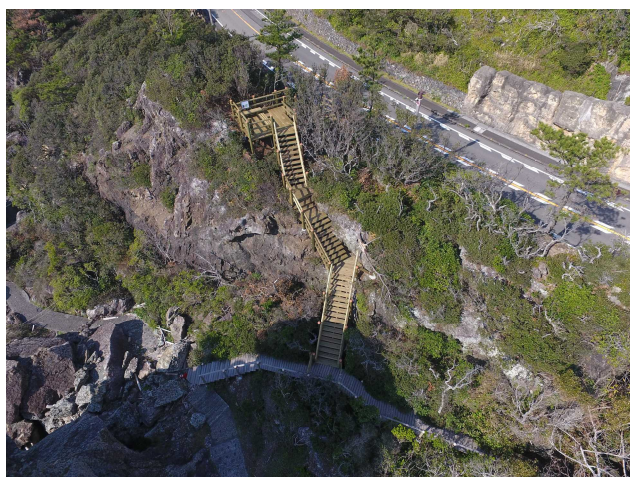
室戸岬園地遊歩道落石対策工事
