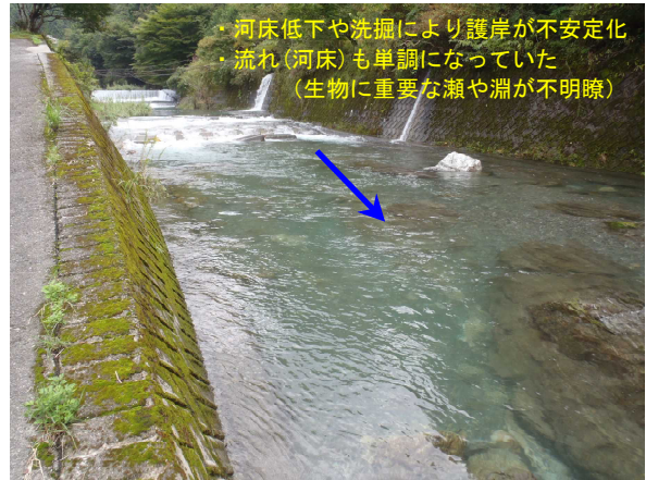
着工前（狩山川：仁淀川町見ノ越）
