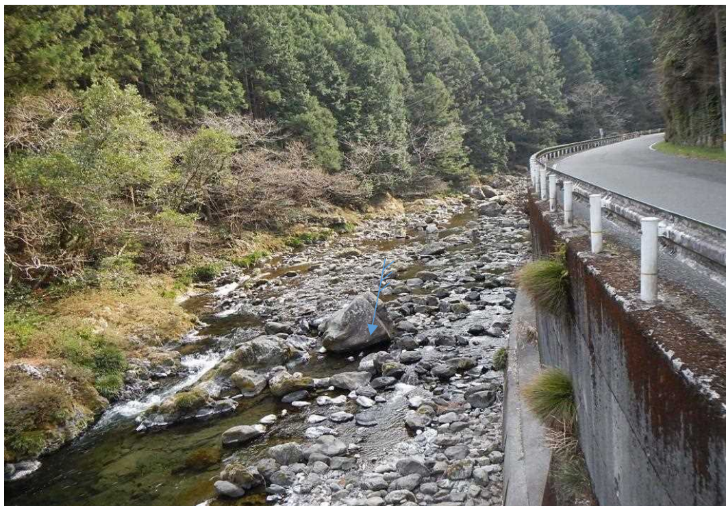
（桐見ダム上流状況）
