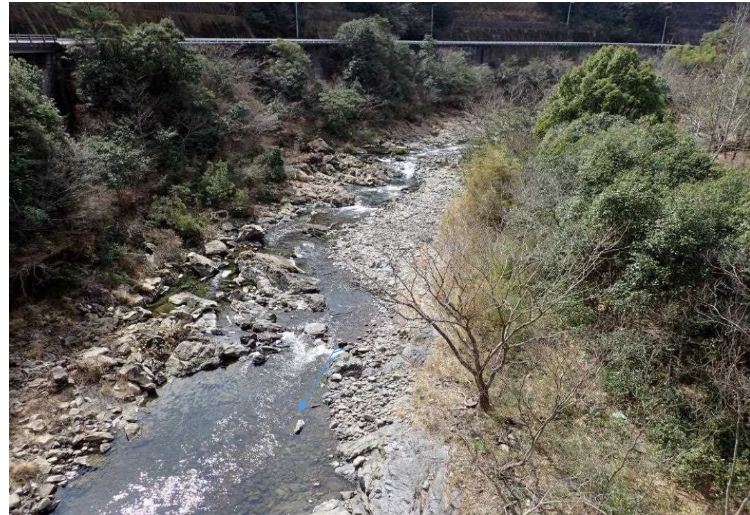
（ダム上流状況）
