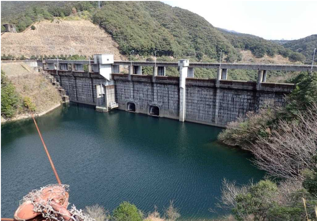
（ダム直上流状況）
