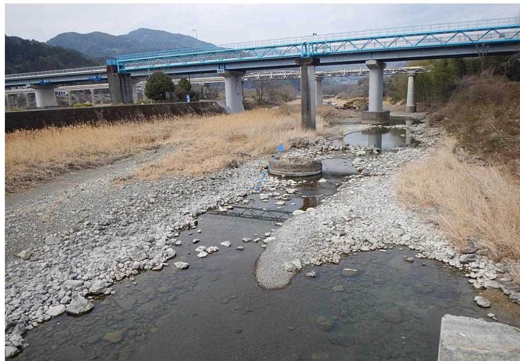
（桐見ダム下流状況）
