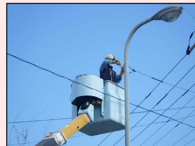
道路照明のLED化の様子
