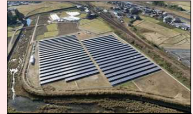
県も出資している県内の太陽光発電施設
