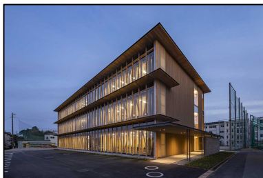
CLTを利用した木造建築物 (高知学園大学)
