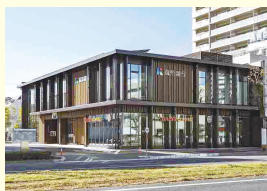
高知県内のZEB事例(高知銀行南支店)
