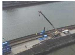
【国分川】 (河川堤防の耐震対策)
