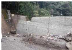
【瀬戸ヶ谷川】 (砂防堰堤の整備)
