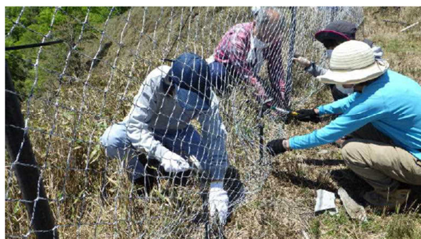
シカ防護ネット設置作業
