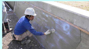
老朽化した水路壁のコーティング
