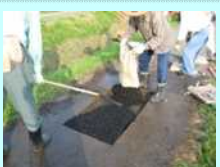
農道の部分補修
