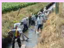
水路の泥上げ
