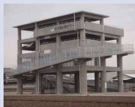
津波避難タワー
