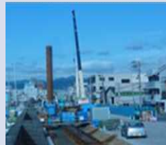
海岸堤防の耐震補強
