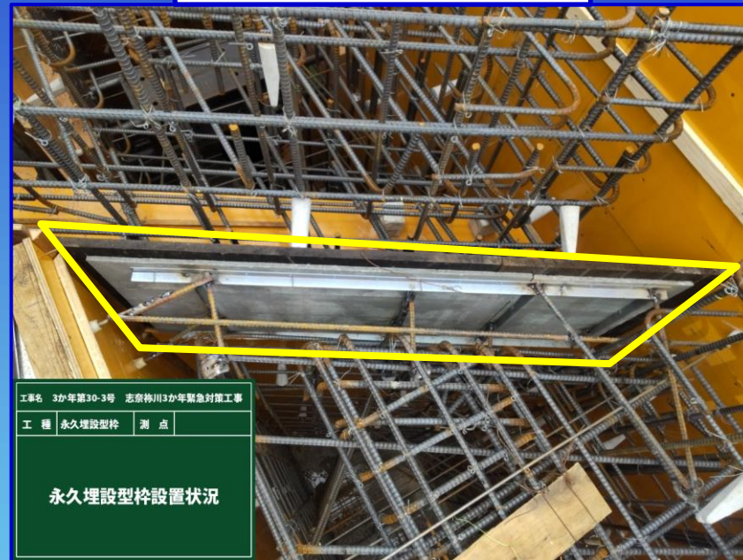
目地部に永久埋設型枠
