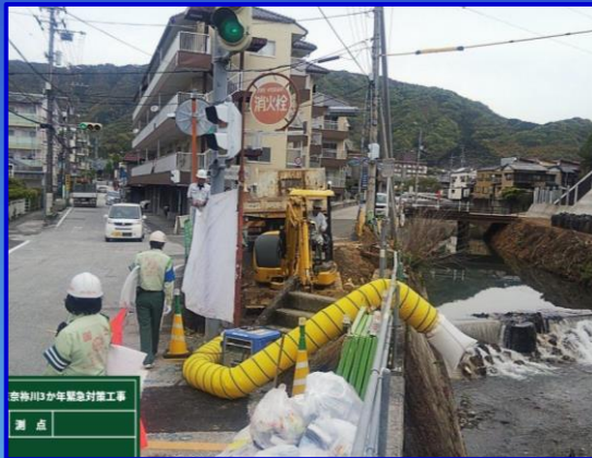
取壊・破碎時の粉塵対策として送風機型集塵機使用
