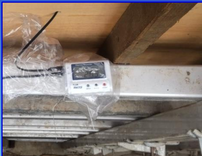
コンクリートの内外部にデジタル温度計
