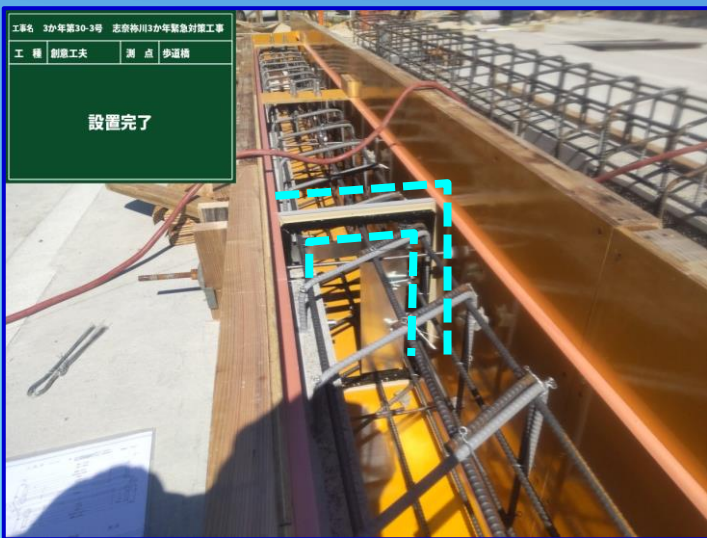
誘発目地材の設置
