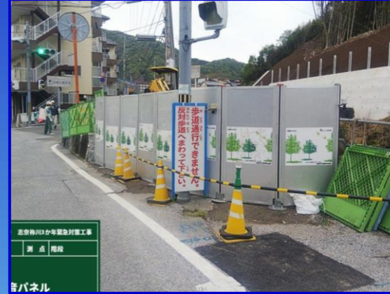
現道横には 防音(吸音)パネルを設置
