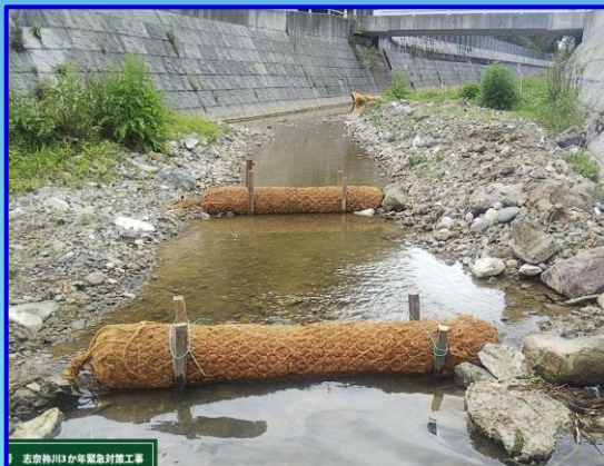
環境配慮型濁水処理フィルター (バイオグフィルター)使用
