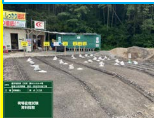
試験盛土実施
