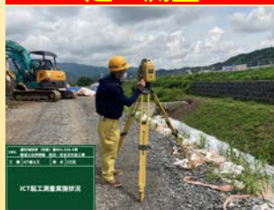
TLSによる 起工測量
