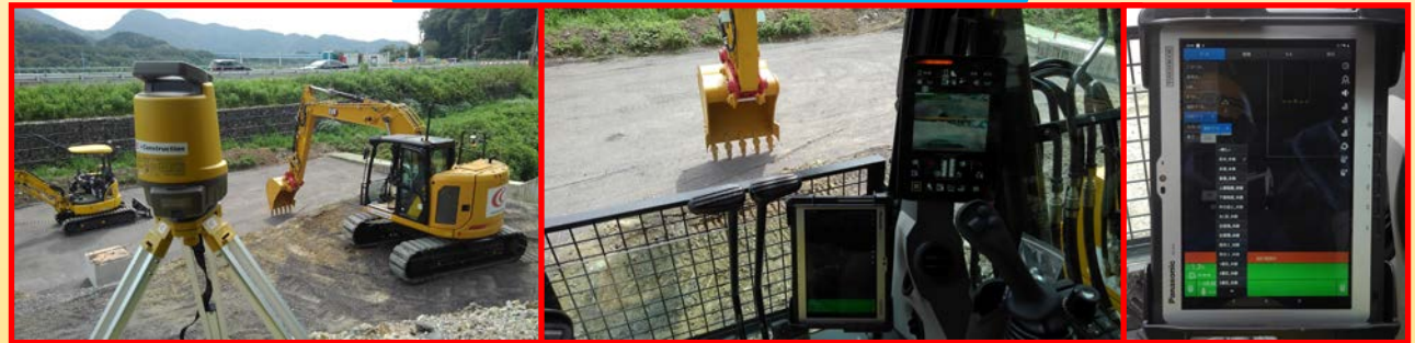
杭ナビショベルによる計測
