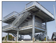
〔津波避難タワー〕
