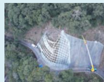
法面防災対策 (県道清王新田貝ノ川線)
