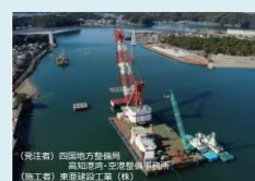
三重防護事業 (湾口防波堤)
