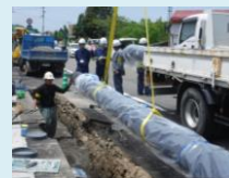
上水道管路の耐震化
