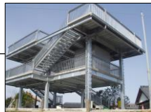
〔津波避難タワー〕
