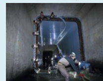
下水道管路の耐震化
