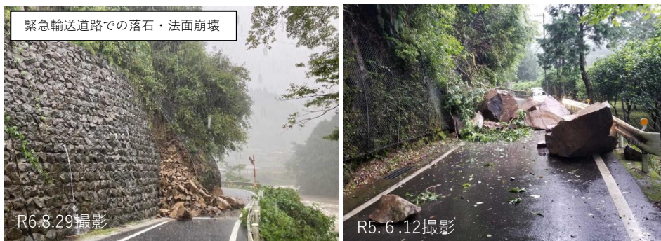
国道439号（津野町北川）
