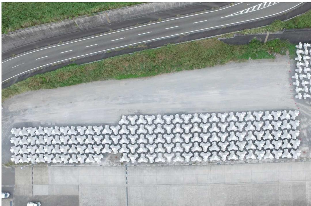
離岸堤 1式 消波ブロック製作(20t) N=150個
