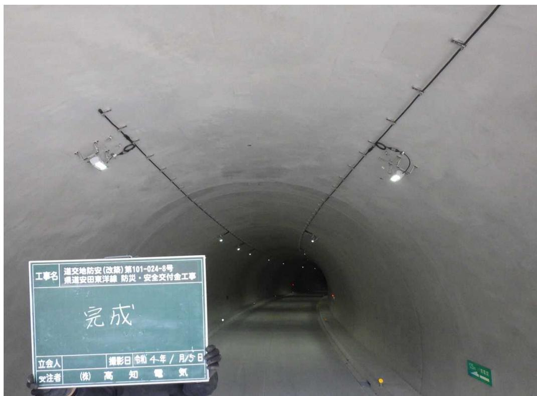
トンネル照明設備工(明神口トンネルL=679m)
