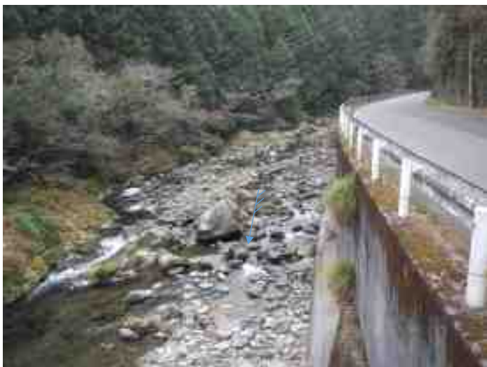
(桐見ダム上流状況)
