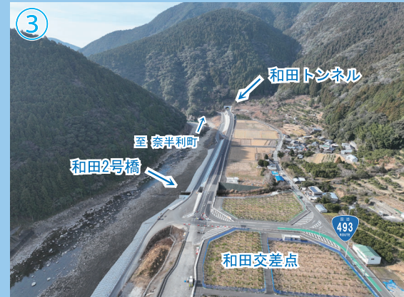
〔和田トンネル起点側〕
