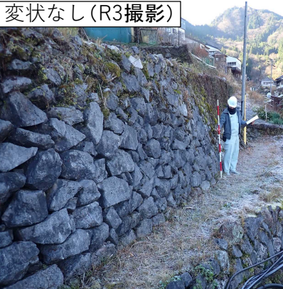
写真① C1ブロック末端部の状況
