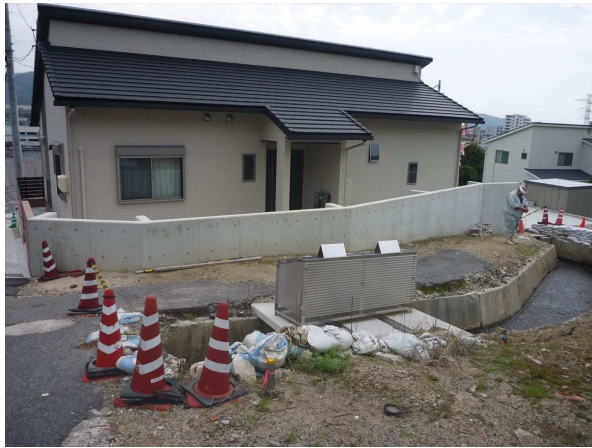
写真 3.2.3 建物対策（レッドゾーン対応：防護壁型式）の設置イメージ
