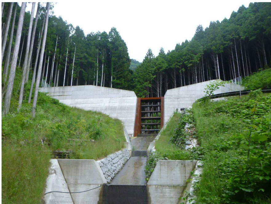
写真 4.2.2 砂防堰堤の設置例（透過型堰堤）
