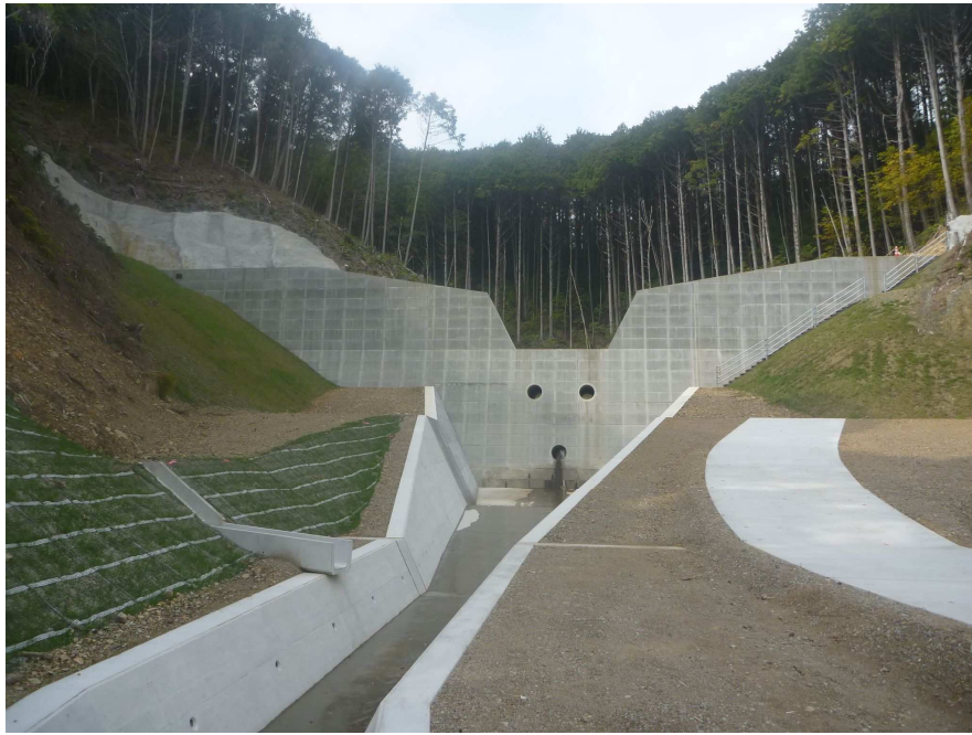
写真 4.2.1 砂防堰堤の設置例（不透過型堰堤）
