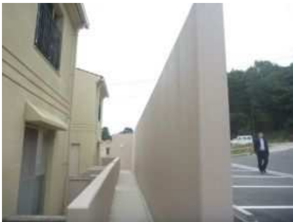
写真 4.2.4 建物対策（建物内への土砂侵入防止対策）のイメージ
