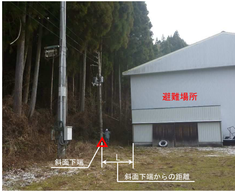
写真 2.2.1 斜面下端と避難場所までの距離の現地確認状況
