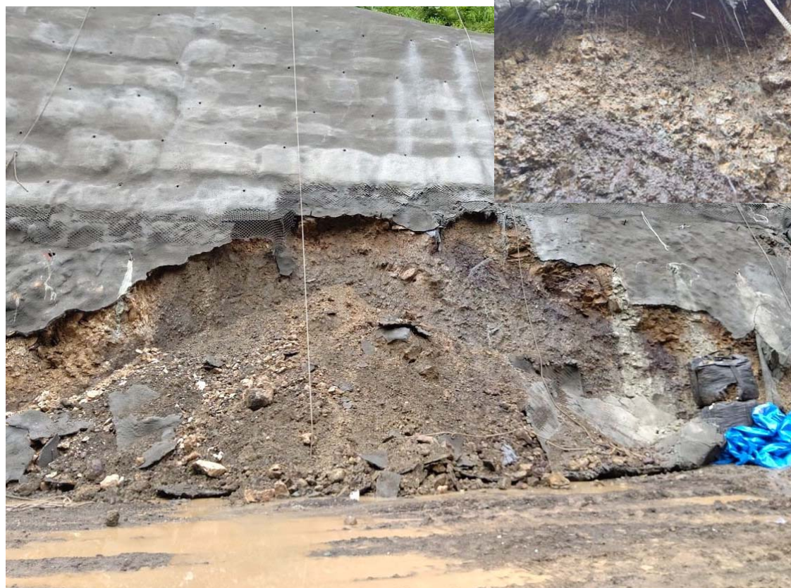
降雨による法面崩落状況
