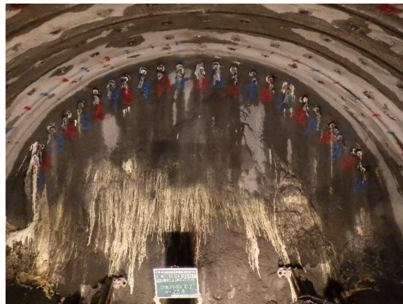
長尺鋼管フォアポーリング(AGF工法)
