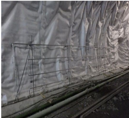
クーリングパイプ設置状況
