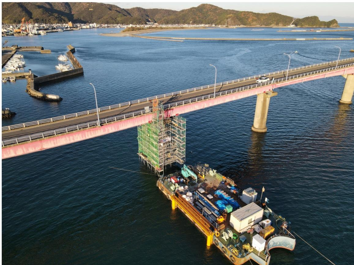
アンカーへの負荷が減少し、台船の長期間の定点係留が可能となることで、台船移動やアンカーの張り直しの手間が減少し、航跡波による揺動も減少
