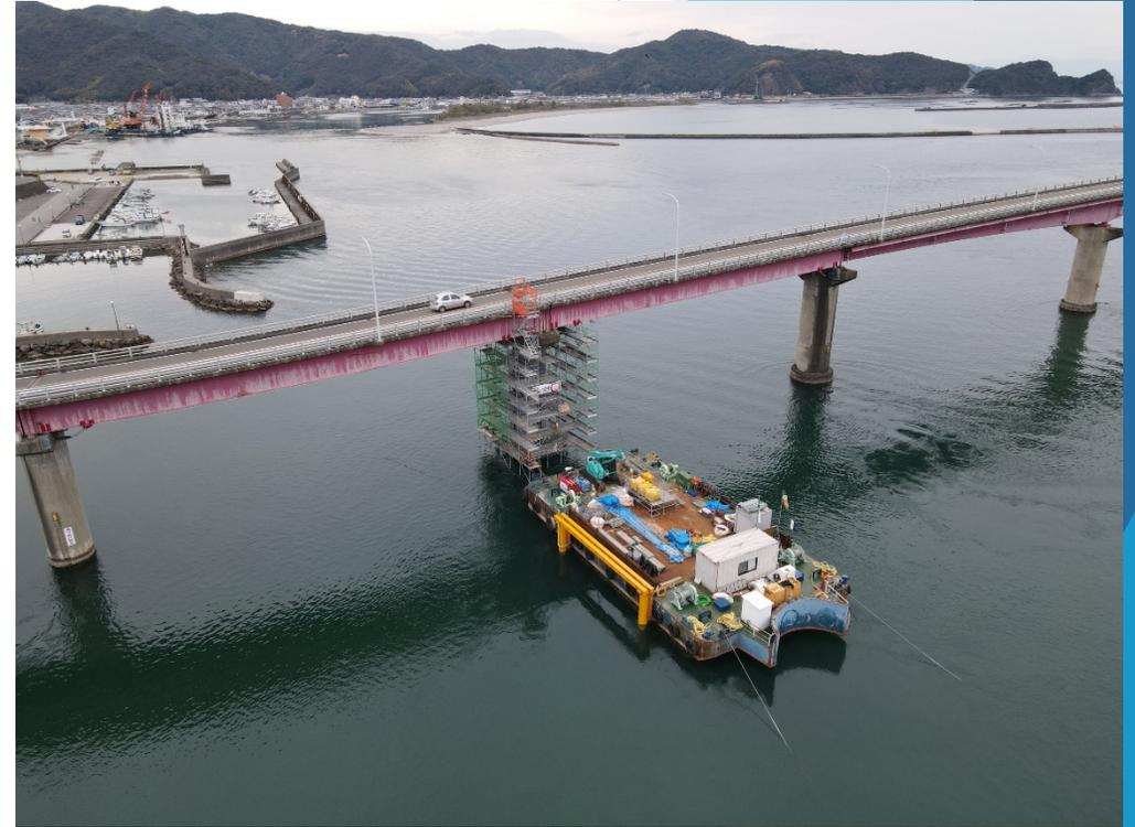
係留用鋼管杭を設置し、クレーン付台船の係留を補助
