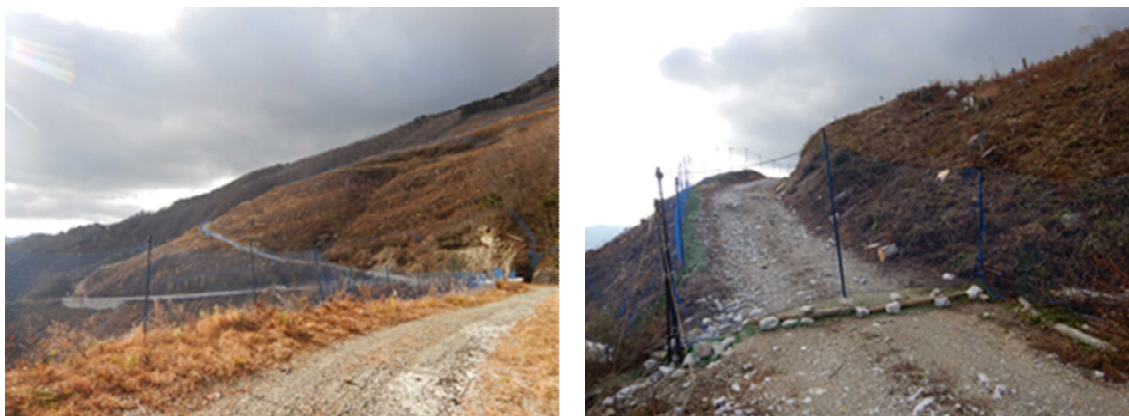
新たに苗木が植栽される民有林の造林地に設置された防鹿柵（いの町高藪）
